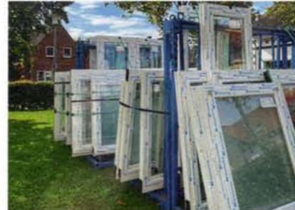
Für die Fenster wurde das Profilsystem Profine 76 MD verwendet, das sich perfekt für die Sanierung eignet.
