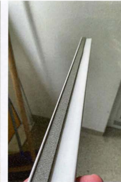
Um die Fensteranschlussfugen optimal abzudichten, wurde hier das Hannoband-BG1 eingesetzt.
