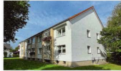
Bei der Sanierung des Wohnhauses verantwortete der Montagebetrieb Haß die Fenstererneuerung.
